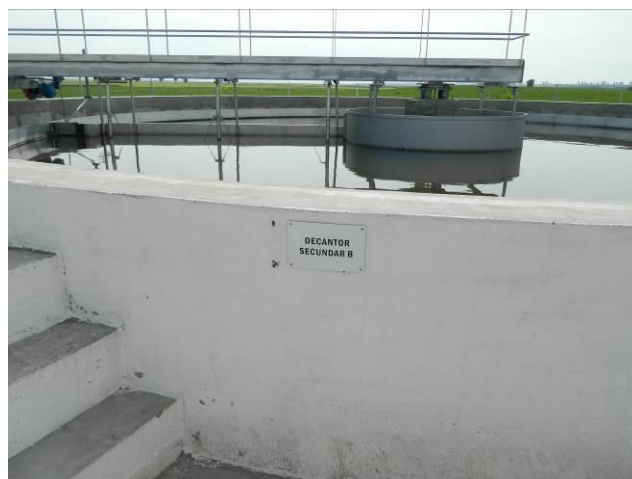
Figura nr. 2.10.31 Decantare secundare
