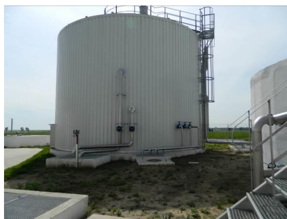
Figura nr. 2.10.35 Bazin fermentare namol
