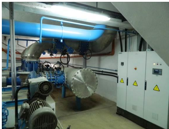
Figura 2.10.7 Statie de pompare –inlocuiri instalatii hidraulice
