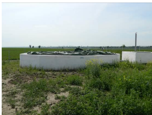
Figura nr. 2.10.32 Bazin stocare biogas
