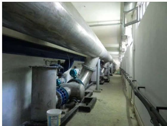
Figura 2.10. 4 Stație de filtre reabilitată – stație de filtre și galeria de conducte
