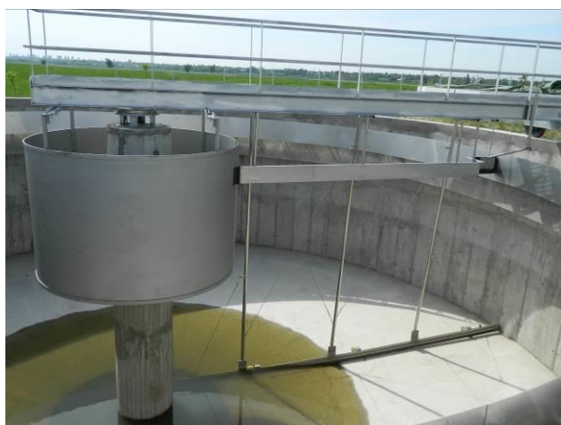
Figura nr. 2.10.31 Decantare secundare
