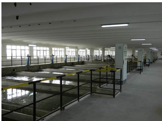
Figura 2.10. 4 Stație de filtre reabilitată – stație de filtre și galeria de conducte
