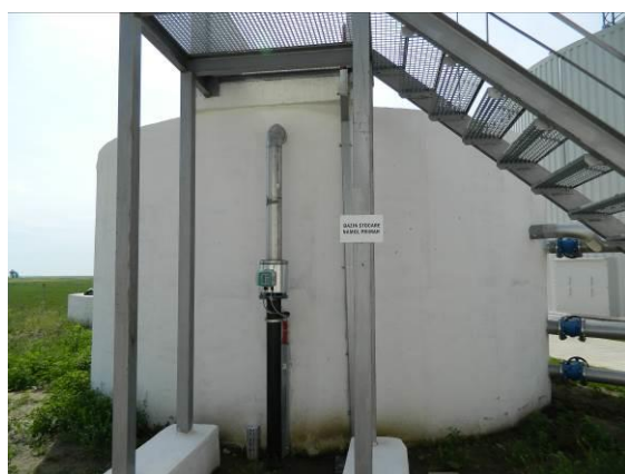
Figura nr. 2.10.34 Bazin stocare namol primar
